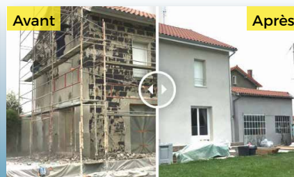
Avant Après Maison rénovation mâchefer avec finition brossée
